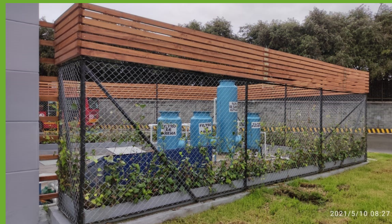
Fotografía. Sí18 (2021) PTAR 2
