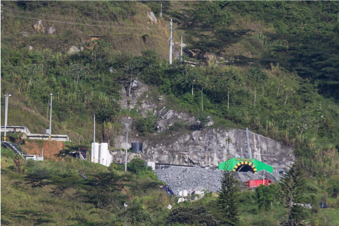
Foto 2. Entrada al socavón. Fuente. Consultora ambiental
